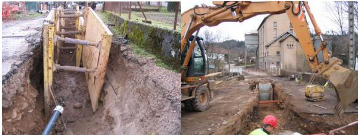
Conduite rue du Moulin
