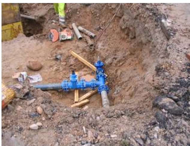
Branchement de la nouvelle conduite au carrefour de la rue du Moulin et de la RD73
